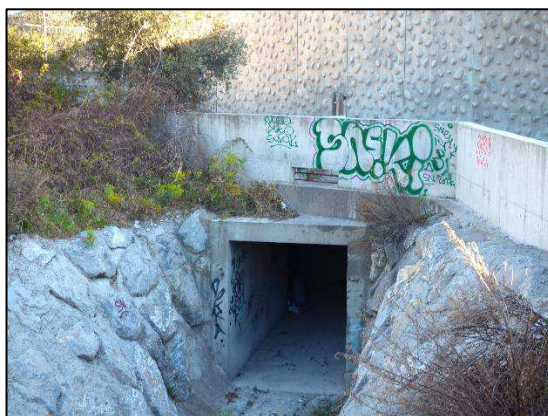
Buse entre le canal au nord et le Var, surplombée du mur anti-bruit A. BÉA (ECO-MED), LA GAUDE
